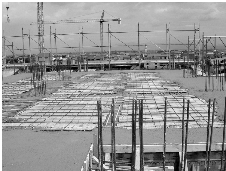
Fig. 6.28 - Fase di getto di un solaio latero-cementizio in opera. Si noti come si gettano prima le travi fino al livello delle pignatte e poi si realizza il getto finale dello spessore della caldana. Si notino ancora i ferri di attesa dei pilastri.
