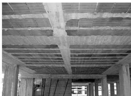
Fig. 6.29 - Travetto rompitratta
