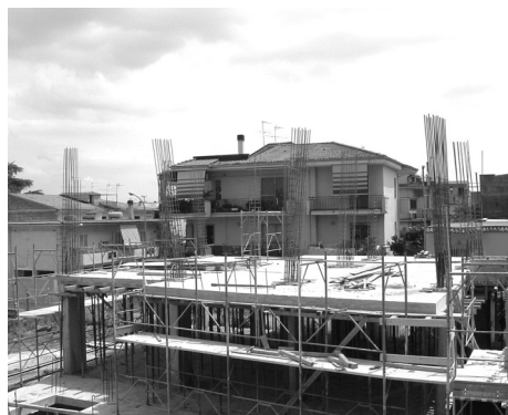
Fig. 6.19 - Armatura di pilastri in c.a. gettati in opera prima della disposizione dei casseri.
