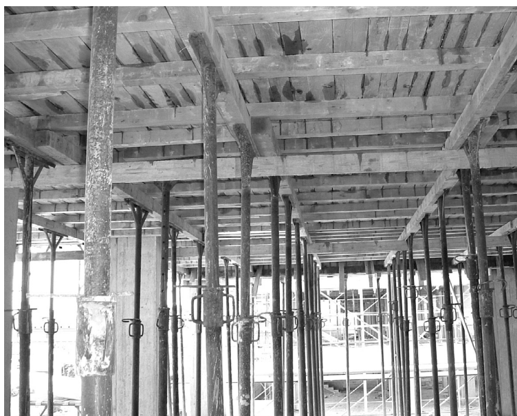
Fig. 6.24- La stessa cassaforma di Fig. 6.20 vista da diversa angolazione. La foto è stata scattata dopo l'ultimazione della e il getto di cls.
