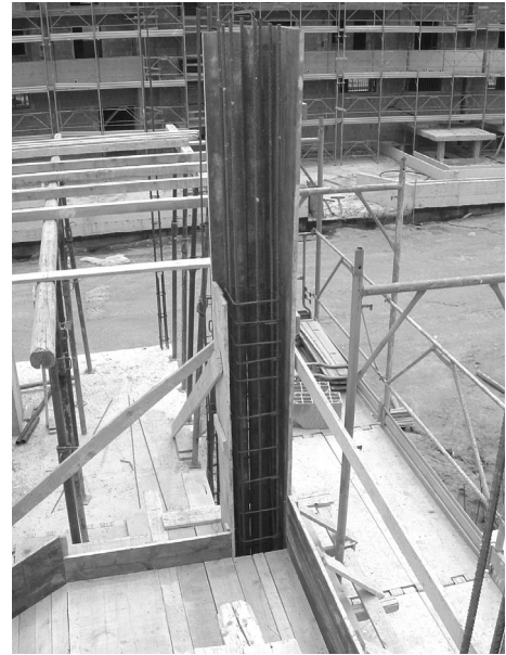
Fig. 6.21- Casserature di un pilastro di un vano scala in corso di realizzazione
