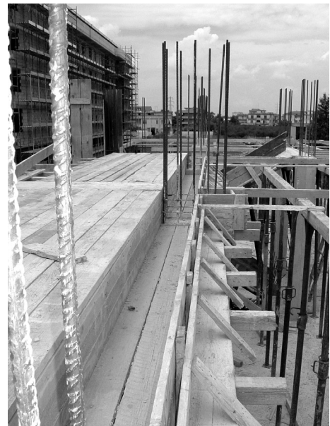
Fig. 6.22- Cassero di una trave alta in corso di realizzazione. Si notino i ferri di attesa dei pilastri e le staffe dei pilastri all'interno della trave.
