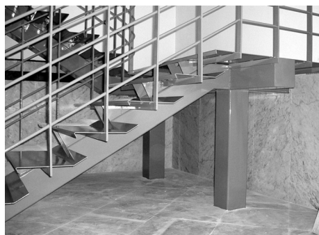
Fig. 6.39 - Scala interna in acciaio. La struttura è realizzata con uno scatolare centrale sul quale sono fissate a "bilancino" i gradini in lamiera sagomata.
