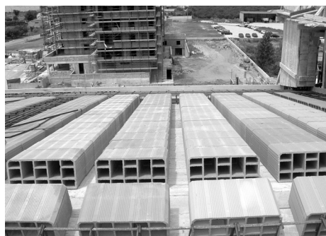
Fig. 6.25- Disposizione delle pignatte prima del getto di cls. Nello specifico la foto si riferisce ad un solaio latero-cementizio inclinato di copertura.
