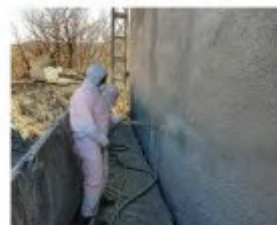
4. L'impermeabilizzazione della superficie
