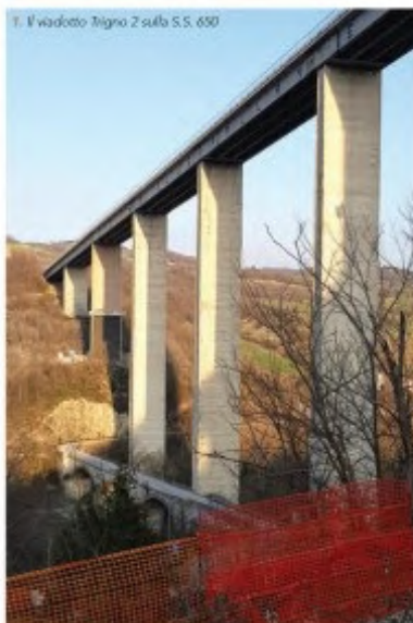
T. Viadotto Trigno 2 sulla S.S. 650
