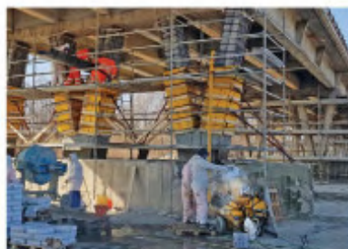
7. La B100 durante la preparazione del materiale e il getto del betonino
