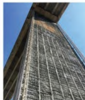
3. La superficie della pile pronta per l'applicazione della malta
