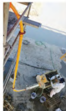
8. Il pompaggio del betonino con il kit di tubazioni in acciaio
