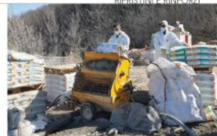
4. La B100 in fase di mescolazione e pompaggio del materiale
