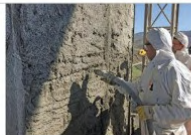
2. La spruzzatura della malta Basf MasterEmaco 5 499 FR tramite la B100
