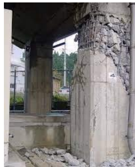
Rottura a taglio o a pressoflessione degli elementi principali
