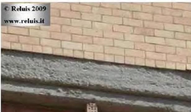
Rottura nel piano e/o fuori piano di tamponamenti leggeri in laterizio non adeguatamente giunti e rispetto al telaio
