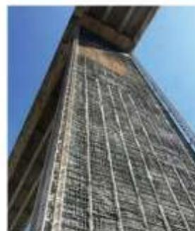
4. La superficie della pile pronta per l'applicazione della malta
