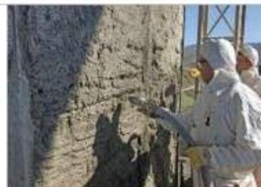
2. La spruzzatura della malta Basf MasterEmaco S 499 FR tramite la B100
