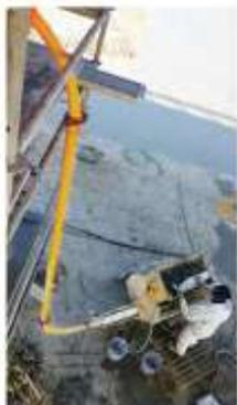
8. Il pompaggio del betonino con il kit di tubazioni in acciaio
