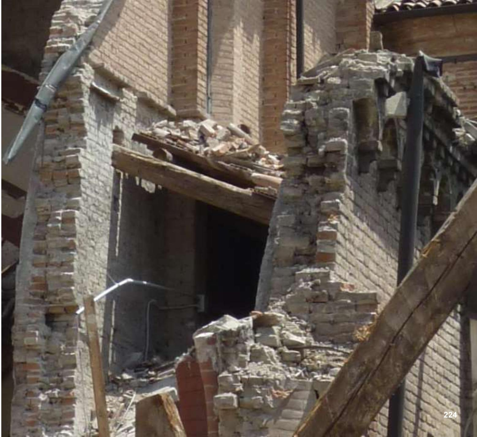
Meccanismo di danno **MODO 0: "disgregazione"** delle murature
