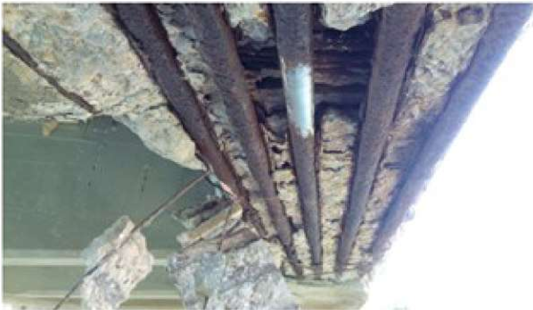
Figure 5. Thrust beam – Concrete cover expulsion, reinforcement corrosion /Trave reggispinta – Espulsione del copriferro, corrosione dell'armatura longitudinale e sfaldamento dell'armatura trasversale
