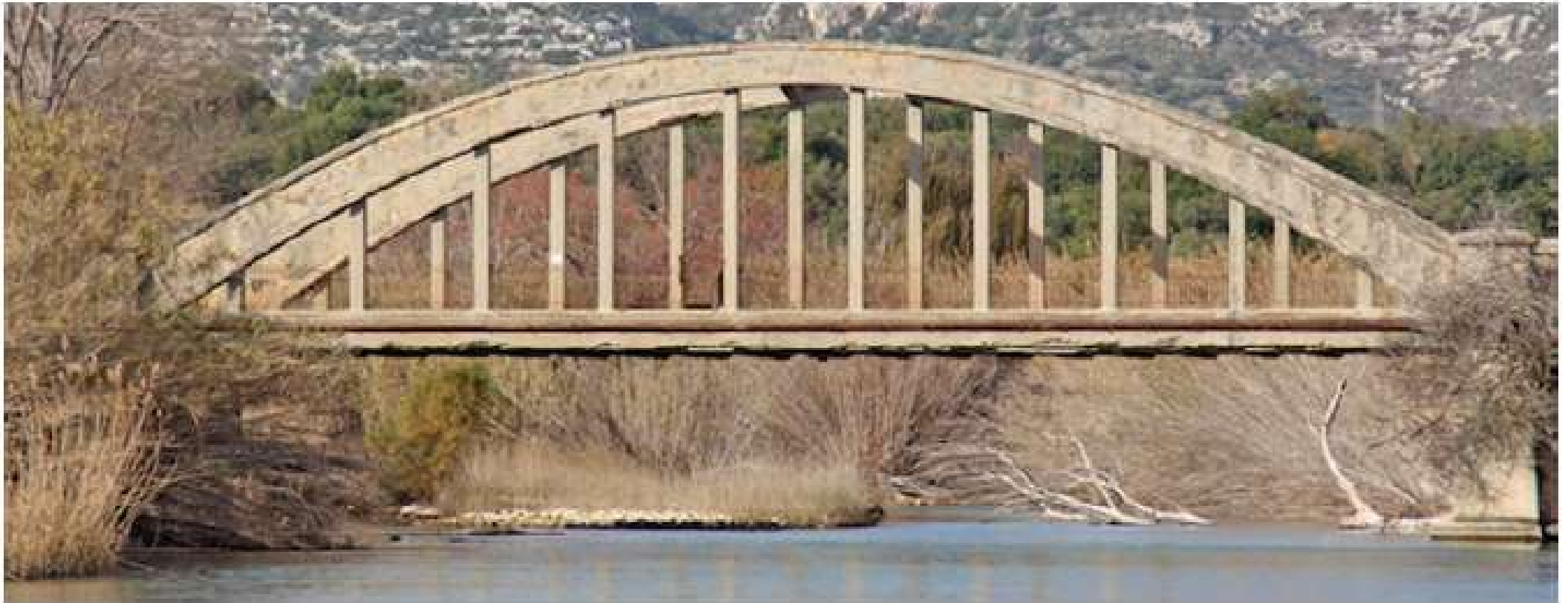
Figure 1. Bridge on the Cassibile river/ Ponte sul Fiume Cassibile
