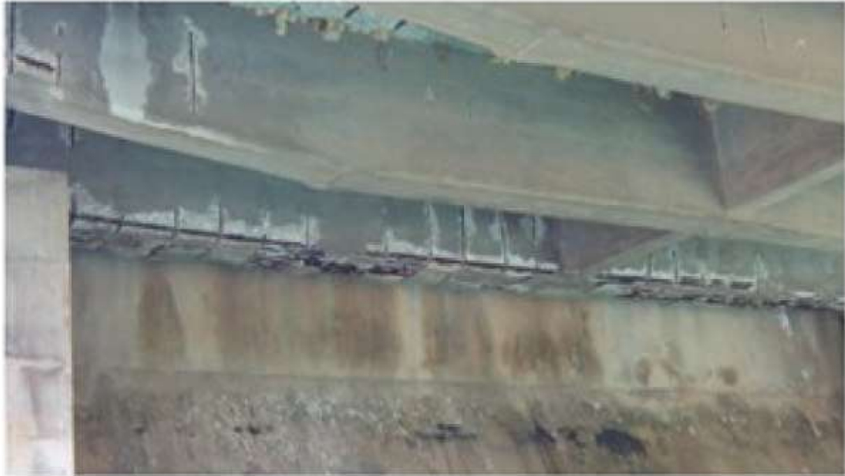
Figure 4. Degradation of cross tested beam with concrete cover spalling and longitudinal and cross bars corrosion /Degrado del traverso di testata con espulsione del copriferro e corrosione delle barre longitudinali e trasversali.
